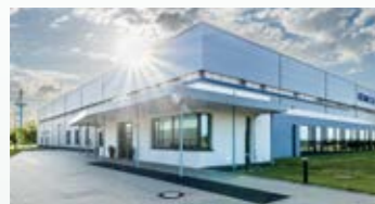
Bautzen DC4データセンター(ドイツ)
