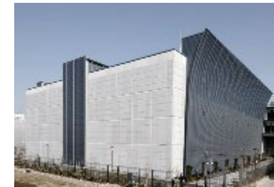
NTT DATA 三鷹データセンター EAST棟
