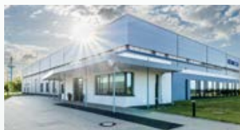
Bautzen DC4データセンター(ドイツ)
