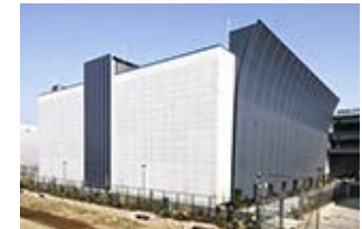
「三鷹データセンタEAST」
