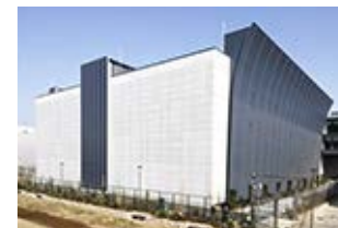
「三鷹データセンタEAST」
